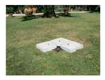
2. Appoggiare il "piede" sui prigionieri sporgenti dalla base e **serrare con forza i 4 dadi in dotazione (per misure sotto i 4x4 metri)**. A operazione completata, sincerarsi che il piede sia "a livella", e, se necessario, correggere l'inclinazione inserendo degli spessori sotto il lato della base che risulta essere più basso.
